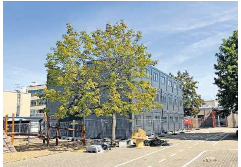
Die neu aufgestellten Container-Klassenzimmer (Foto: Stadt Würth am Rhein)
