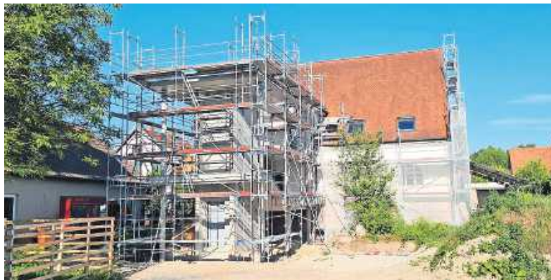
Das neue Greenhouse wird der barrierefreie Zugang zum alten Pfarrhaus mit Möglichkeit sich bei Sonne hier aufzuhalten - von der Gartenseite ist es schon gut zu erkennen
