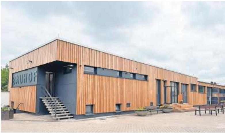
Das Gebäude wurde mit einer vorgehängten und hinterlüfteten Holzfassade verkleidet
